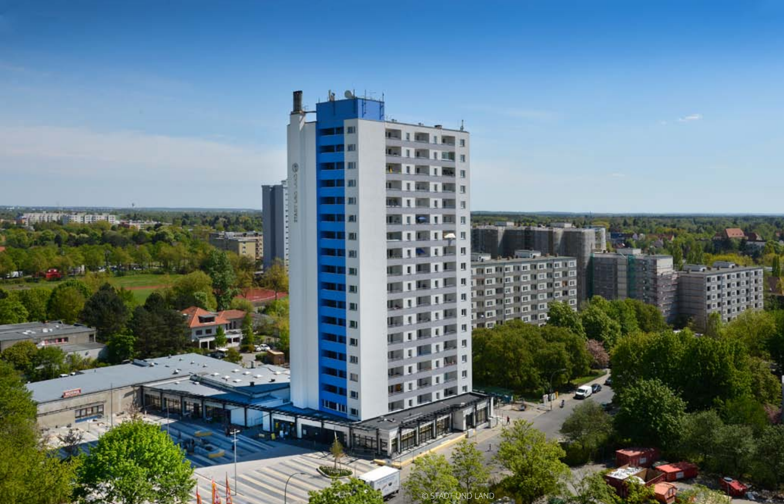
Von 2013 bis 2018 ist die John-Locke-Siedlung das größte Sanierungsprojekt und damit ein wesentlicher Investitionsschwerpunkt der STADT UND LAND.
